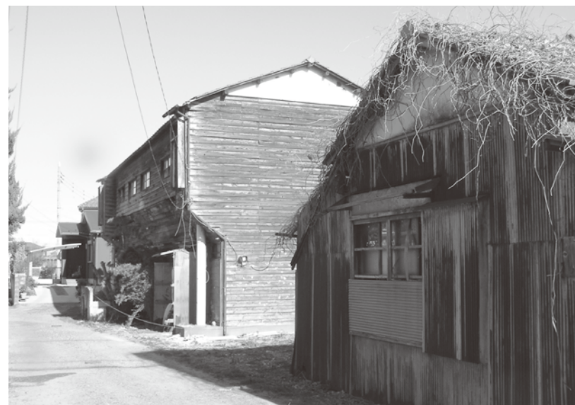
倒壊や火災も心配！早急な撤去が求められている空き家
