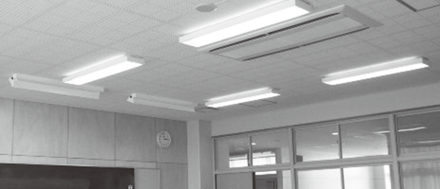
新築校舎についてエアコン (他市の中学校)
