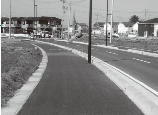
着々と工事が進む道仏土地区画整理事業地内
