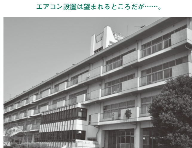
エアコン設置は望まれるところだが……。
