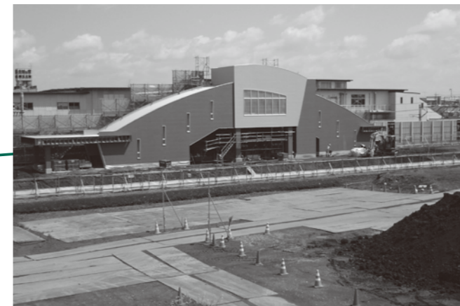
新跨線橋 5月13日に使用開始予定。駅改 札口と駅前広場が直接つながり便利になる。 トイレと交番の設置が望まれる。
