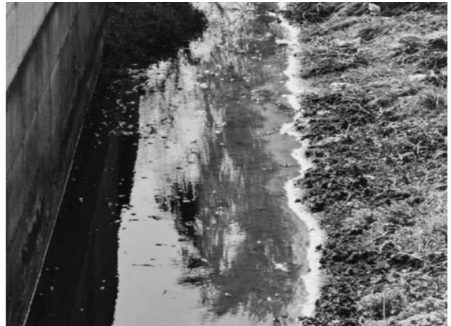
未だにある改修されない排水路
