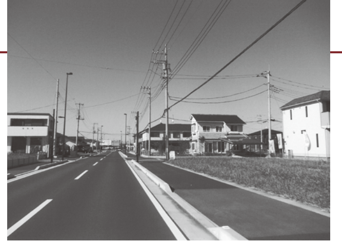
定住人口増に向けて建築が進む道仏土地区画整理地内
