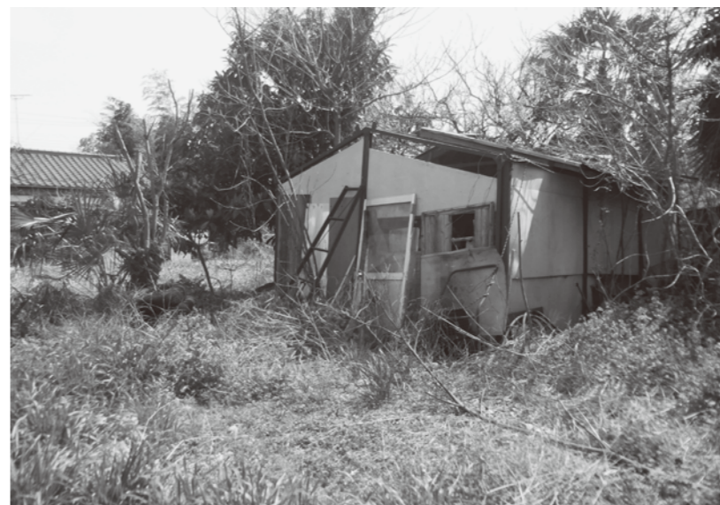
空き地に壊れかけた建物（倉庫？）が…
