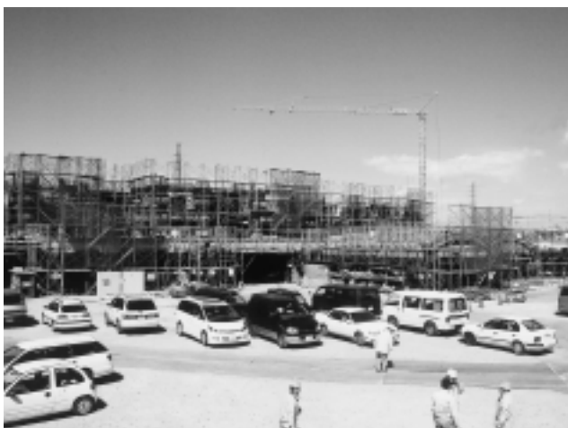
完成間近な(仮称)福祉医療センター
