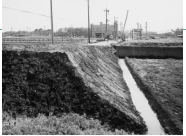
新橋通り線工事予定地
