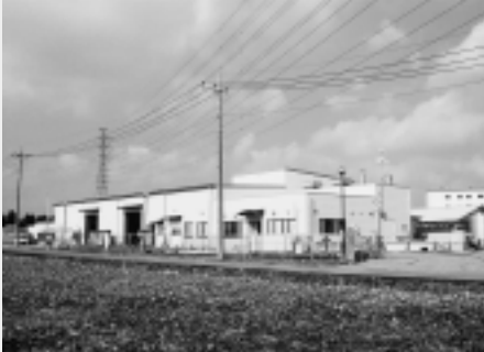
完成した堆肥化施設
