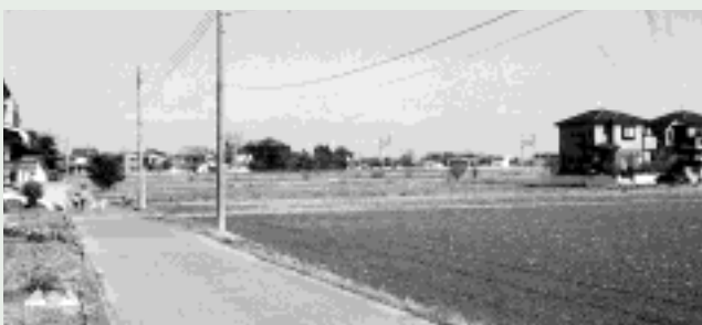
事業が進行する道仏土地区画整理現地
