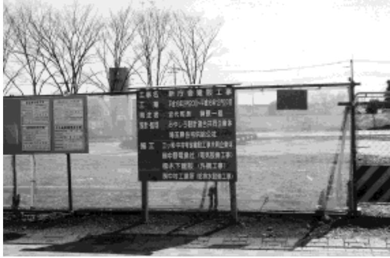
完成が待ち遠しい庁舎
