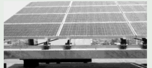
太陽光発電システム
