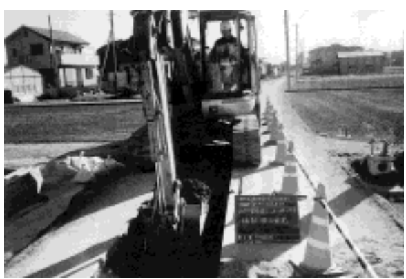
西条原地区で進む、農業集落排水事業
