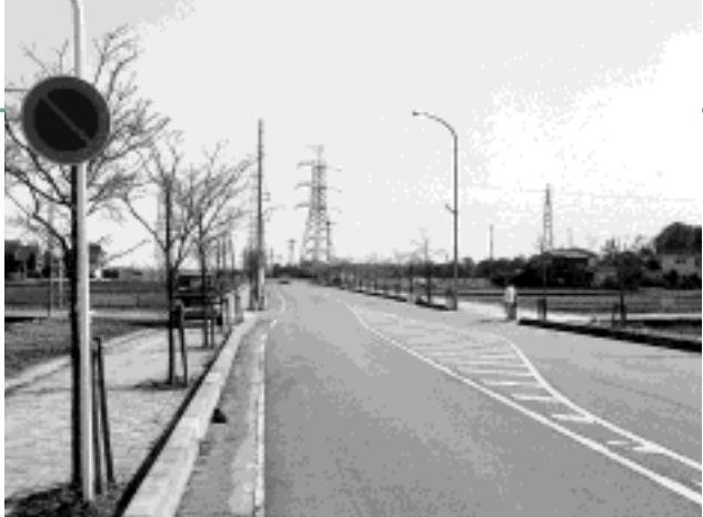
延伸が望まれる都計道路1号線
