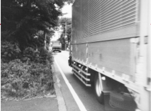
側溝のフタ未整備部分
