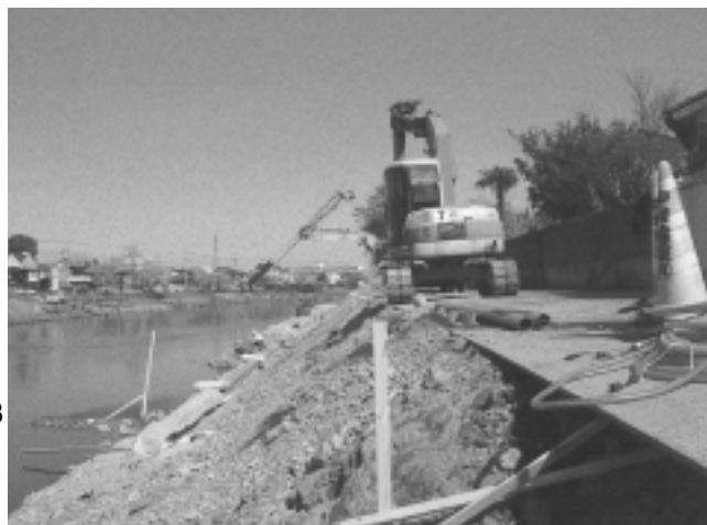
古利根川の護岸工事
