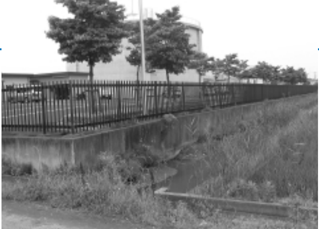
用水路整備が待たれる宮東(水道タンク東脇)
