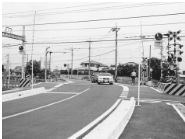
危険な踏切の改良を早く(歩道部分が拡幅された須賀第158号踏切)
