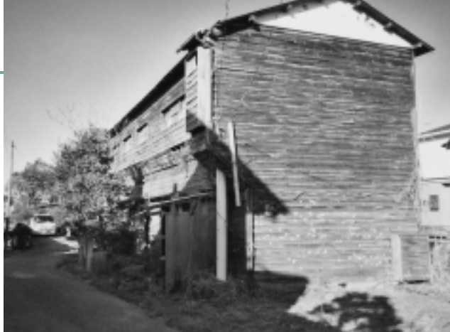
倒壊や火災なども心配！早急な撤去が求められている廃屋
