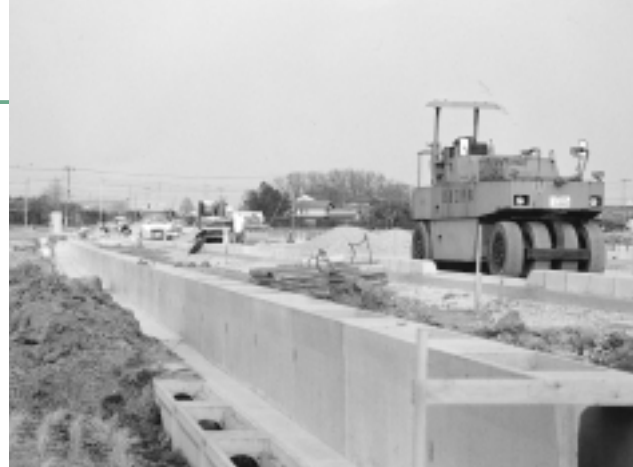
圏央道の側道として完成した都市計画道路備中岐橋通り線
