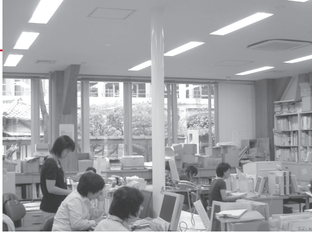
支柱で補強された1階の健康福祉課付近
