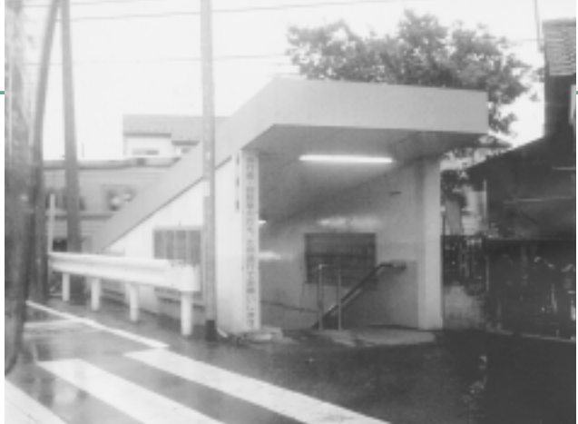
設置がまたれる東小地下道
