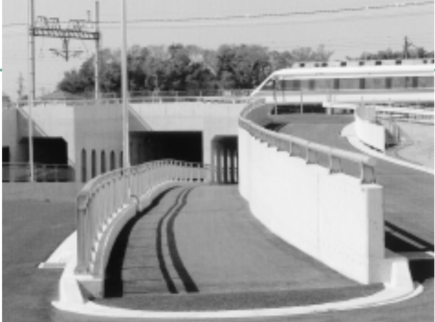
開通が間近い「新橋通り線」(県道蓮田杉戸線バイパス)
