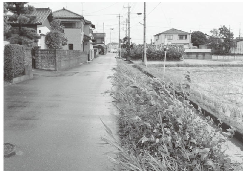
豪雨時は、水路との境目がなくなる道路
