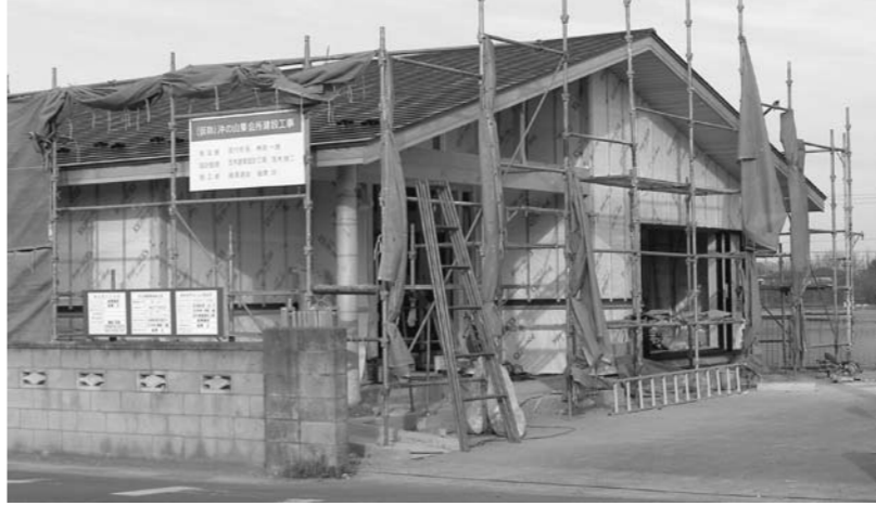
建設が進む(仮称)沖の山集会所
