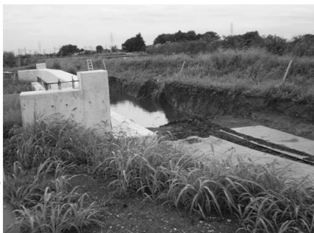
姫宮地内の道路改良工事現場 (右岸下部工)
