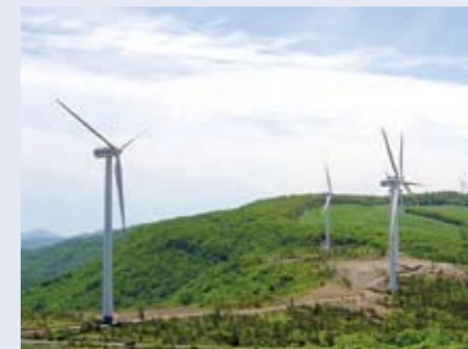
くずまき風力発電所（岩手県葛巻町）
