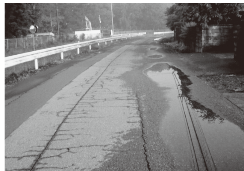
町道409号線（山崎地内）悪路の改善を要望する
