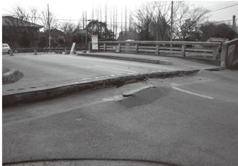
震災直後の蓮谷橋
